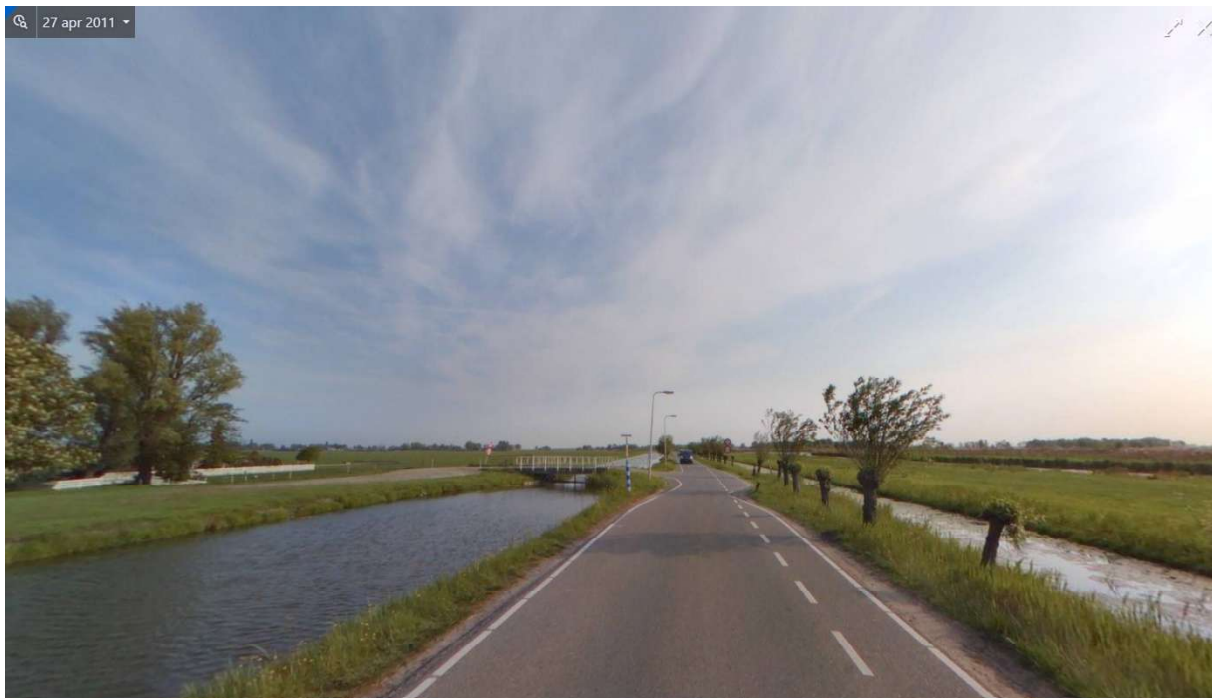
Figuur 5 – Situatie ter hoogte van het kruispunt Zierendeweg – Achtermiddenweg d.d. 27 april 2011 met bermshade [foto: Streetsmart/Cyclomedia]
