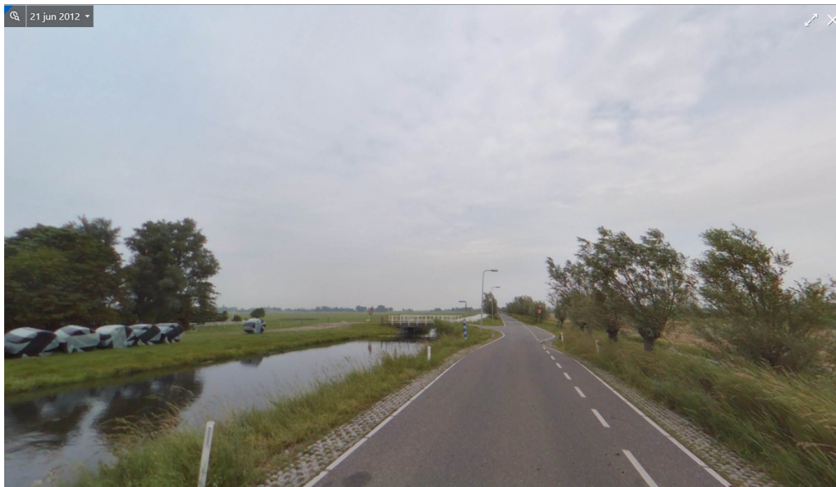
Figuur 6 – Situatie ter hoogte van het kruispunt Zierendeweg – Achtermiddenweg d.d. 21 juni 2012 met doorgroestenen [foto: Streetsmart/Cyclomedia]
